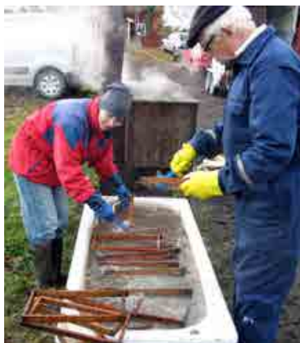
Ramar sköljs efter tvätten.
