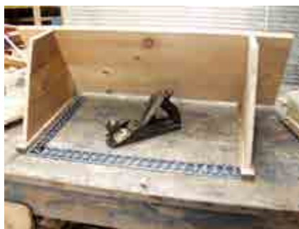
Trågsidorna placeras på avdelningsluckorna som ställts parallellt och rätvinkligt.
