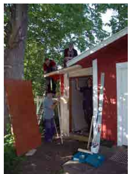
Tillbyggnaden nästan färdig.
