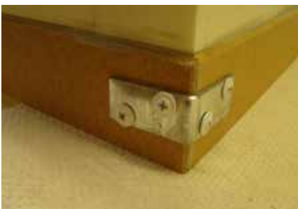
Bild 7 Förstärkning i styrlisthörn.
