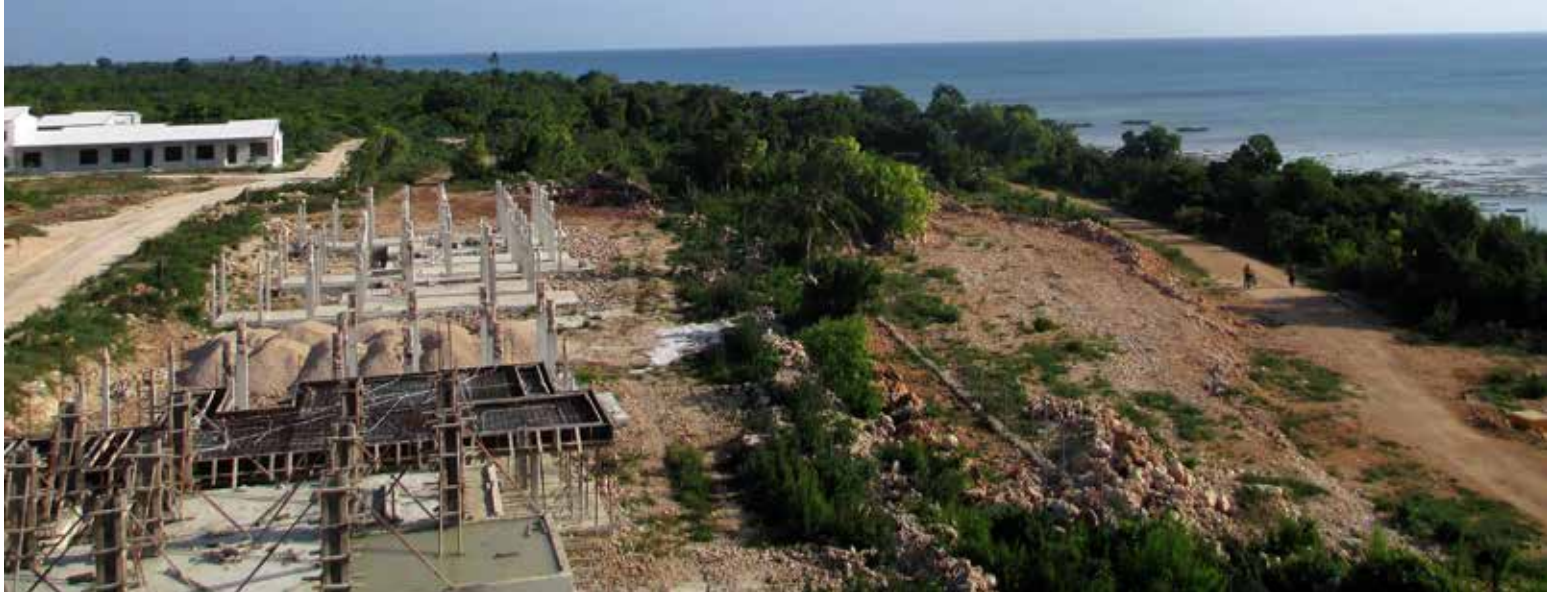
Bygget av den nya staden Fumba Town invid Indiska Oceanen pågår för fullt. Staden kommer att ha sitt egna kretslopp. Renat avloppsvatten används för bevattning.
