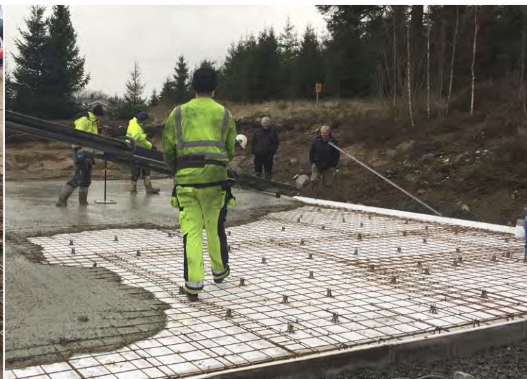
en omgång med armeringsjärnen. Den 9 december när kantelement, isolering och armering var på plats gjöts grunden. Sedan tog vi julleddigt.
