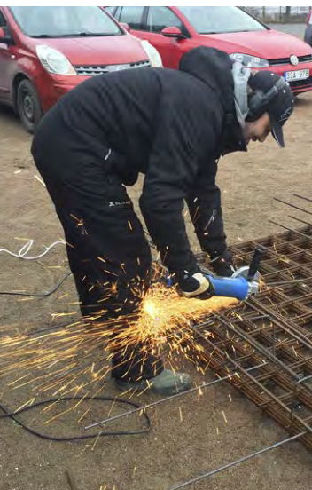
en omgång med armeringsjärnen. Den 9 december när kantelement, isolering och armering var på plats gjöts grunden. Sedan tog vi julleddigt.
