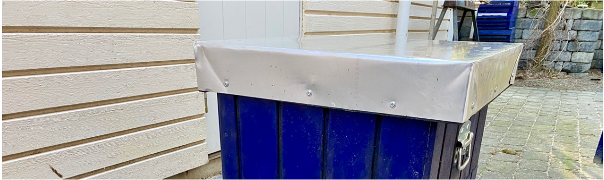
Taket klätt med aluminiumplåt (offsetplåt från tryckeri).
